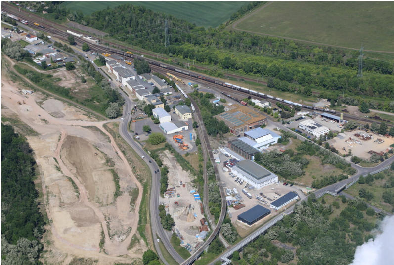
Luftbildaufnahme der Zentralen Werkstätten mit Blick nach Nordost Fotograf/Urheber: Ronald Heynowski
