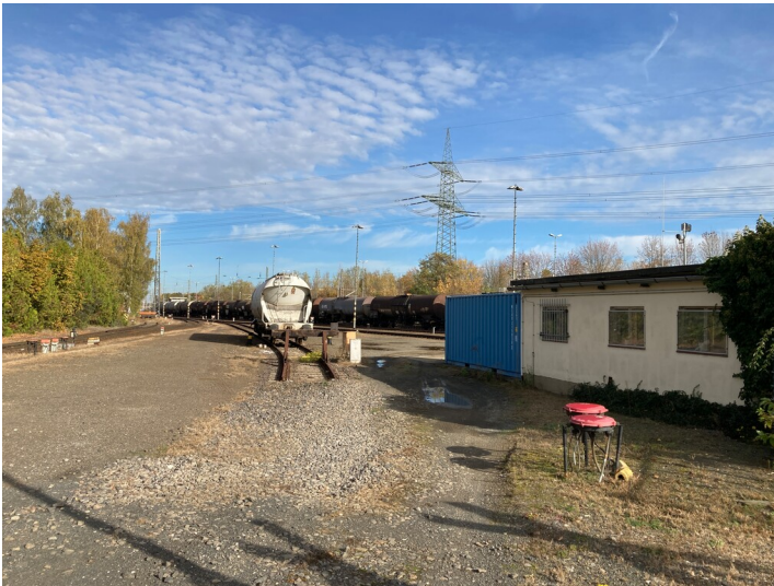
Stellwerk aus südwestlicher Richtung Fotograf/Urheber: Nils Schinker
