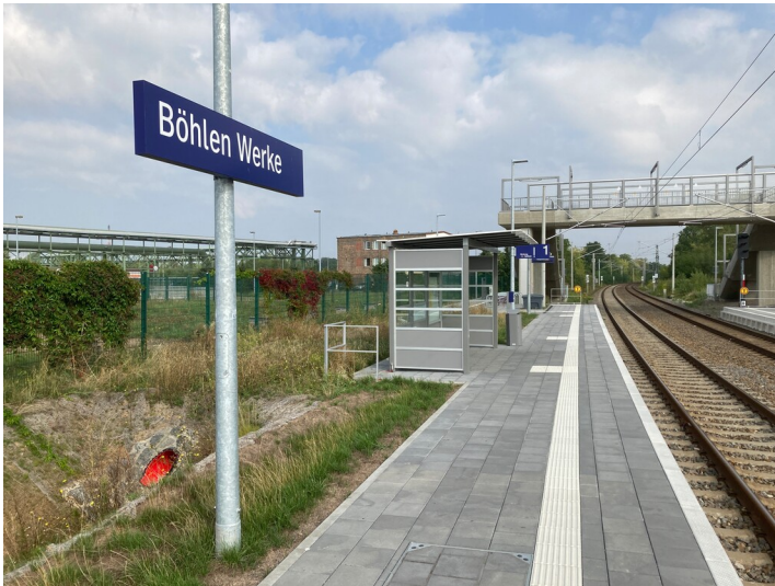
Haltepunkt mit Blick Richtung Norden Fotograf/Urheber: Nils Schinker
