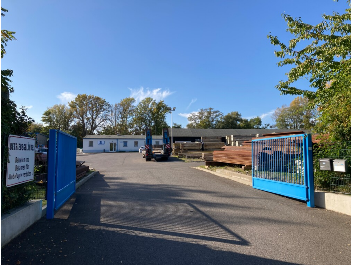
Blick auf den Bauhof mit Lagerplatz von der Werkstraße Fotograf/Urheber: Nils Schinker
