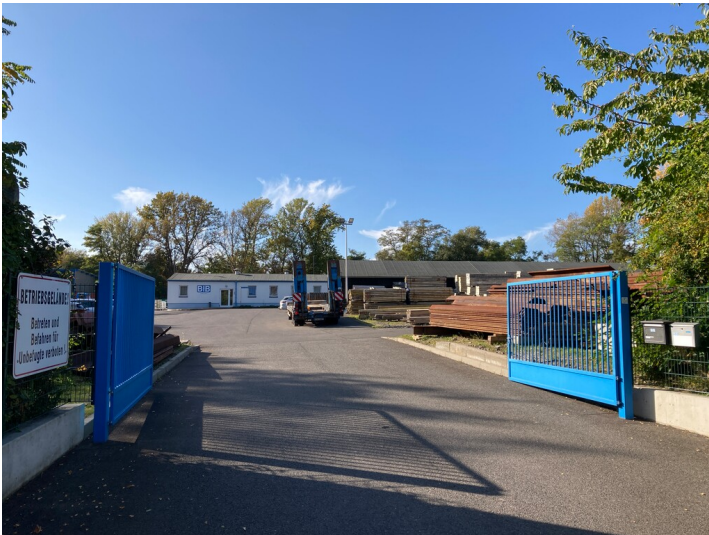
Blick auf den Bauhof mit Lagerplatz von der Werkstraße Fotograf/Urheber: Nils Schinker
