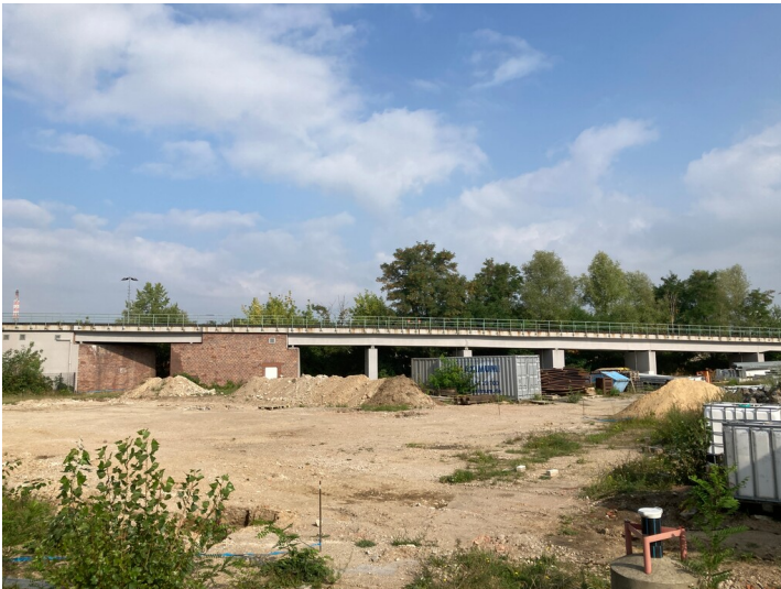
Millionenbrücke über der Werkstraße Fotograf/Urheber: Nils Schinker
