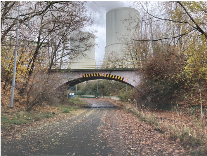
Bogenbrücke mit Wegeunterführung von Norden Fotograf/Urheber: Nils Schinker
