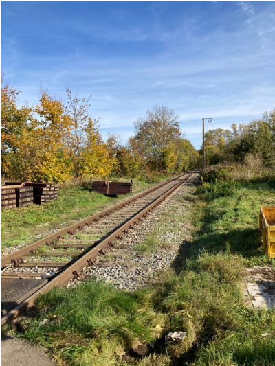
Eisengangleise zwischen Böhlen und Rötha Fotograf/Urheber: Isabell Schmock-Wieczorek
