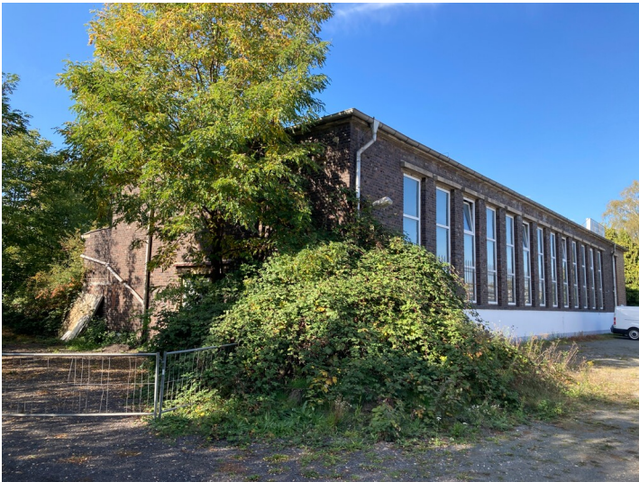
Gleichrichterstation von Südost Fotograf/Urheber: Nils Schinker
