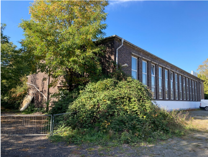
Gleichrichterstation von Südost Fotograf/Urheber: Nils Schinker
