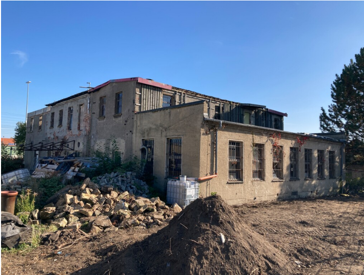
Gebäude aus nordwestlicher Richtung Fotograf/Urheber: Nils Schinker
