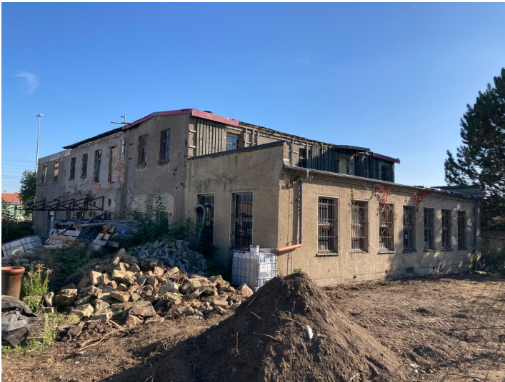
Gebäude aus nordwestlicher Richtung Fotograf/Urheber: Nils Schinker
