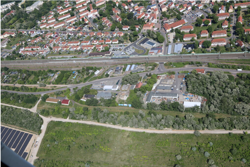
Tagesanlagen im Bildvordergrund westlich der Bahnlinie, Luftbildaufnahme aus westlicher Richtung Fotograf/Urheber: Ronald Heynowski
