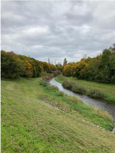
Teilverlegung der Pleiße mit Blick von Straßenbrücke in Deutzen in nördliche Richtung Fotograf/Urheber: Isabell Schmock-Wieczorek
