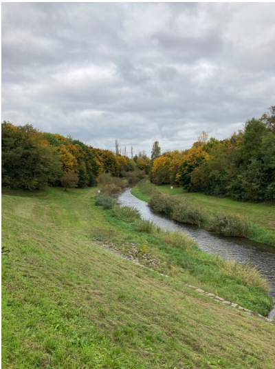
Teilverlegung der Pleiße mit Blick von Straßenbrücke in Deutzen in nördliche Richtung Fotograf/Urheber: Isabell Schmock-Wieczorek
