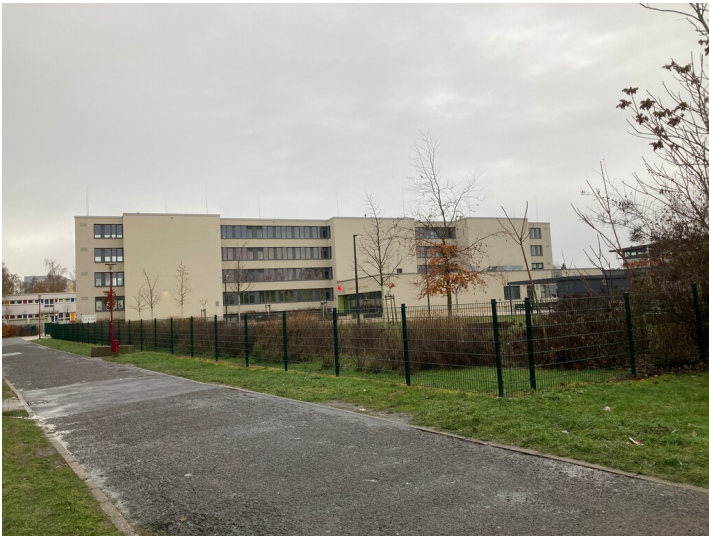
Blick auf die Schule aus nordöstlicher Richtung Fotograf/Urheber: Isabell Schmock-Wieczorek
