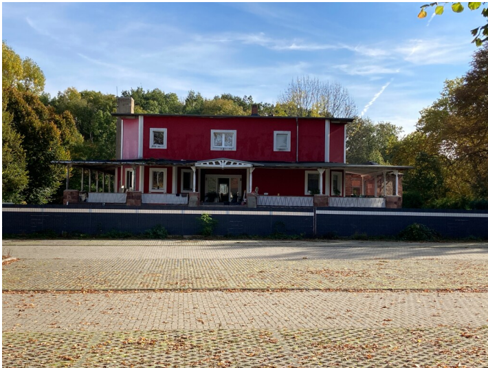
Villa aus westlicher Richtung Fotograf/Urheber: Isabell Schmock-Wieczoreck
