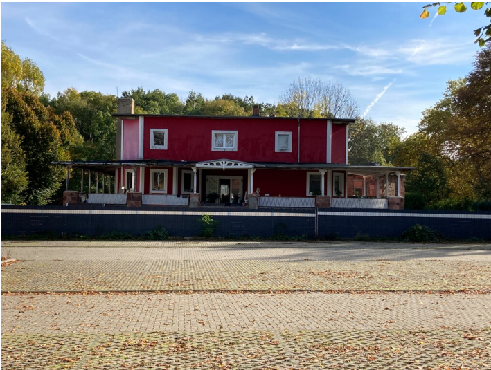
Villa aus westlicher Richtung Fotograf/Urheber: Isabell Schmock-Wieczoreck
