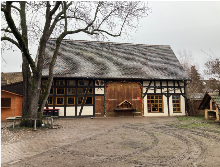
Blick auf südliche Traufseite Fotograf/Urheber: Isabell Schmock-Wieczorek
