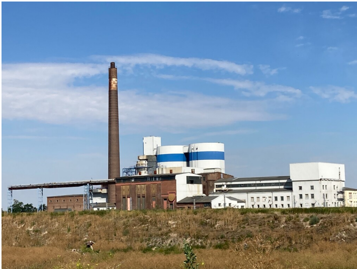
Heizkraftwerk der Zuckerfabrik Delitzsch aus südlicher Richtung Fotograf/Urheber: Isabell Schmock-Wieczorek
