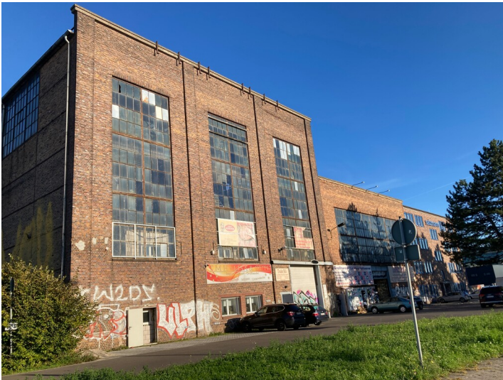
Hallenkomplex im nördlichen Bereich des Industriekomplex mit Blick in Richtung Südosten Fotograf/Urheber: Isabell Schmock-Wieczorek
