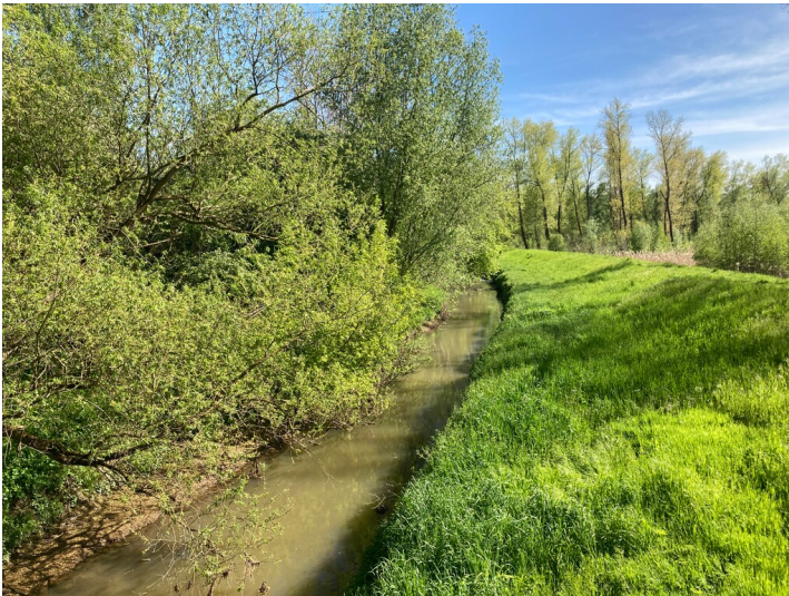
Verlegung der Wyhra östlich von Großzössen Fotograf/Urheber: Isabell Schmock-Wieczorek
