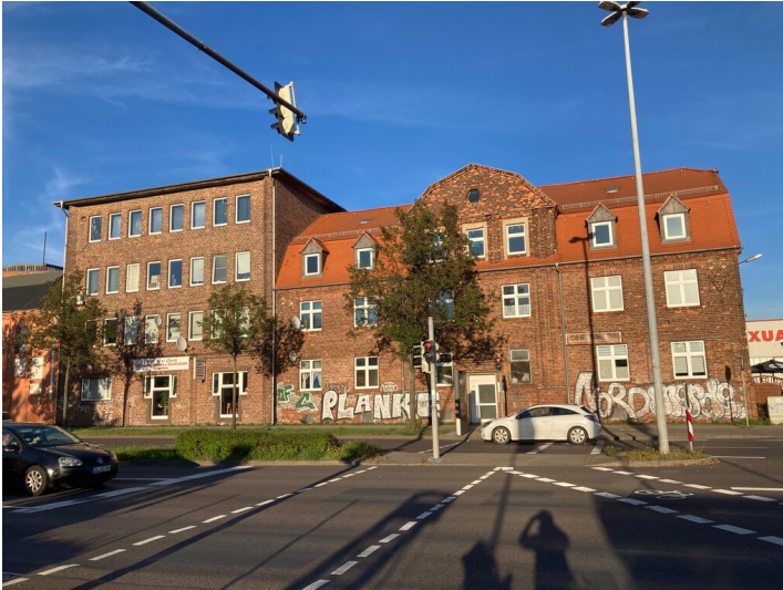
VTA-Verwaltungsgebäude, ehemaliges Beamtenwohnhaus mit Blick in Richtung Osten Fotograf/Urheber: Isabell Schmock-Wieczorek
