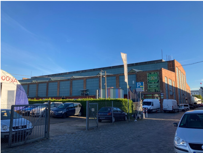
Fabrikhalle B 63 mit Blick Richtung Südosten Fotograf/Urheber: Isabell Schmock-Wieczorek
