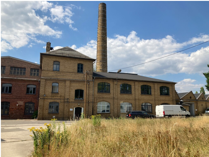
Ansicht des Sozialtraktes des historischen Fabrikkomplexes von Osten Fotograf/Urheber: Isabell Schmock-Wieczorek
