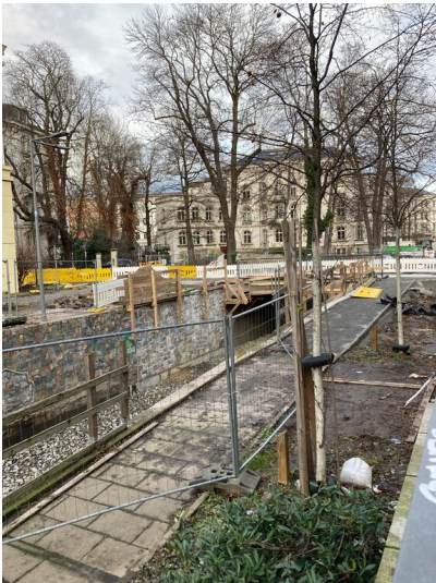
Freilegungsarbeiten des verrohrten Abschnitts am Poniatowskiplatz Fotograf/Urheber: Isabell Schmock-Wieczorek
