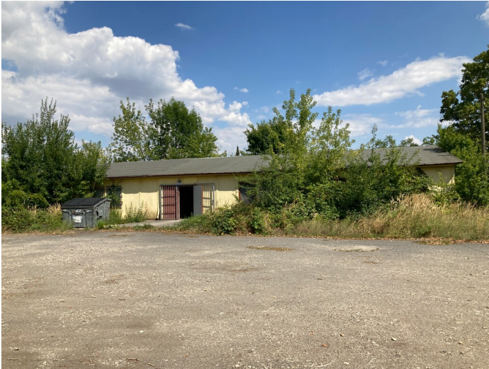
Bürogebäude mit Sicht auf die Westseite des Gebäudes Fotograf/Urheber: Isabell Schmock-Wieczorek
