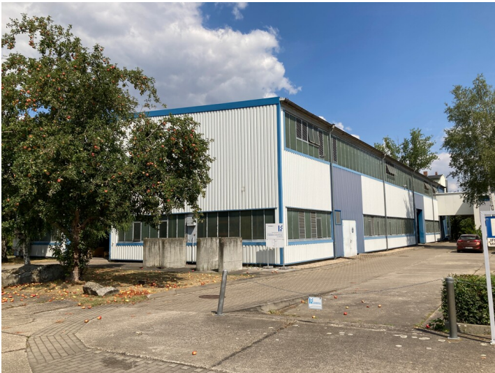
Experimentalbau aus südwestlicher Blickrichtung Fotograf/Urheber: Isabell Schmock-Wieczorek
