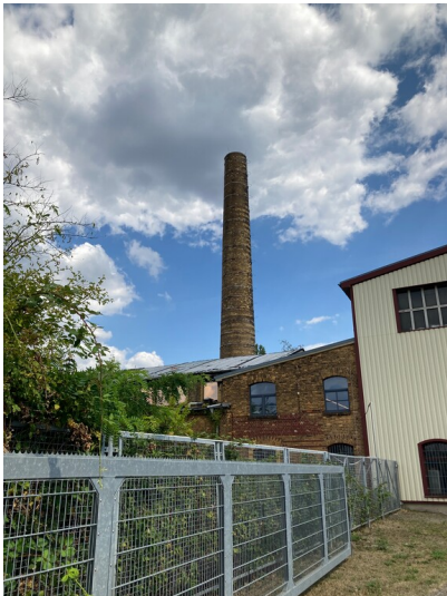
Westseite des Kessel- und Maschinenhauses von Süd Fotograf/Urheber: Isabell Schmock-Wieczorek
