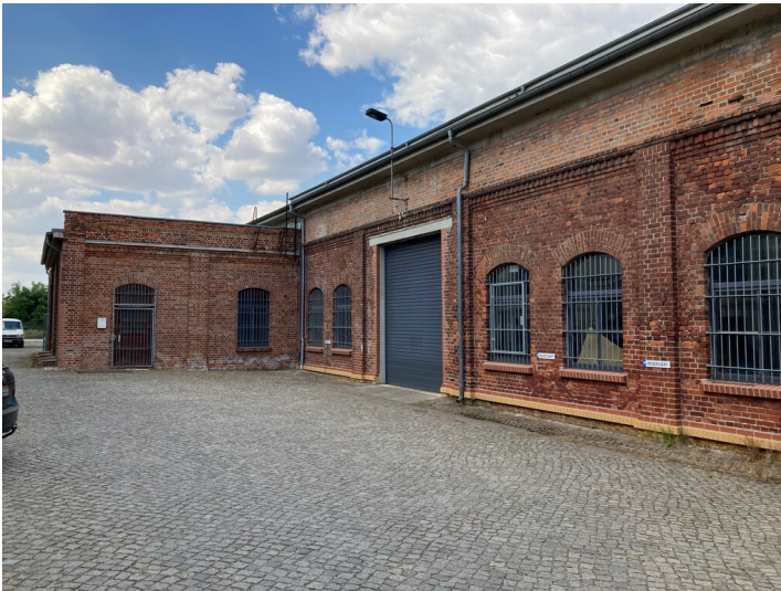
nördliche Gebäudeseite der ehemaligen Montagehalle des Instituts für Fördertechnik Fotograf/Urheber: Isabell Schmock-Wieczorek
