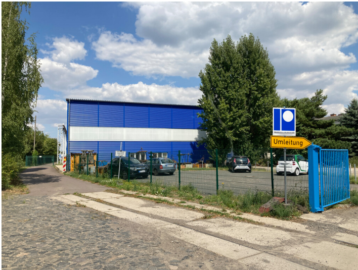
Halle für Versuchskranbahn aus südlicher Blickrichtung Fotograf/Urheber: Isabell Schmock-Wieczorek
