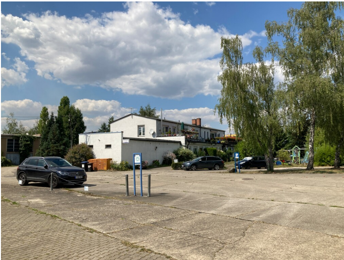
Werkhalle II mit Kesselhausanbau aus südöstlicher Blickrichtung Fotograf/Urheber: Isabell Schmock-Wieczorek
