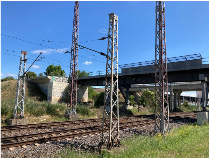
Eisenbahnbrücke Fotograf/Urheber: Nils Schinker
