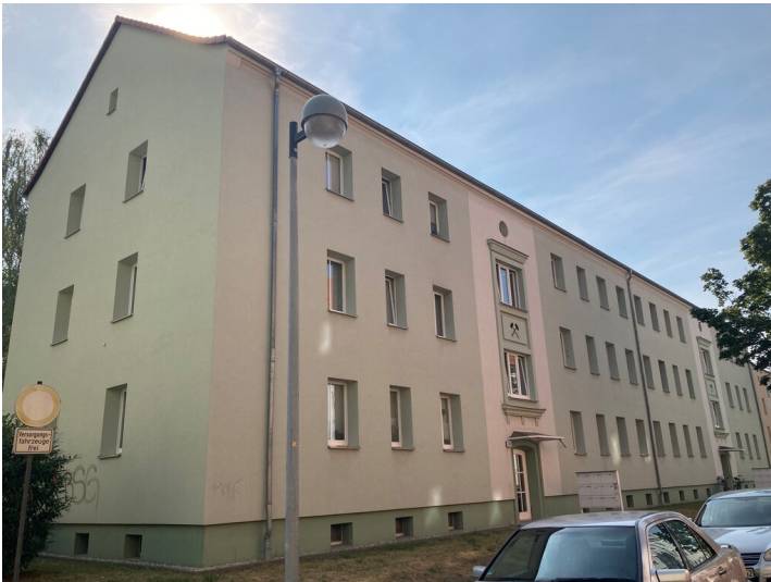
Mehrfamilienwohnhaus aus nordwestlicher Richtung Fotograf/Urheber: Isabell Schmock-Wieczorek
