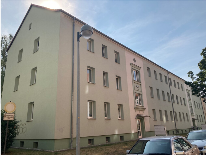
Mehrfamilienwohnhaus aus nordwestlicher Richtung Fotograf/Urheber: Isabell Schmock-Wieczorek
