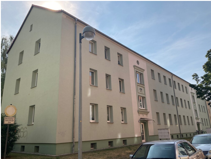
Mehrfamilienwohnhaus aus nordwestlicher Richtung Fotograf/Urheber: Isabell Schmock-Wieczorek
