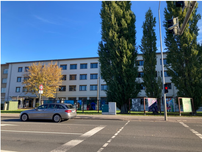
Bürogebäude aus dem ersten Bauabschnitt mit Blick nach Südost Fotograf/Urheber: Isabell Schmock-Wieczorek
