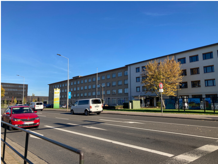
Bürogebäude der ersten Bauphase des Instituts für Energetik mit Blick Richtung Südost Fotograf/Urheber: Isabell Schmock-Wieczorek
