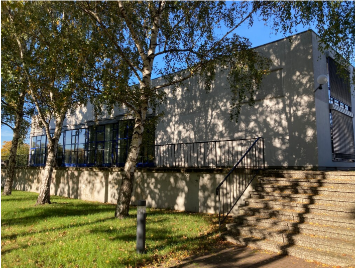
Sozialgebäude des VEB Geophysik Leipzig an der Bautzner Straße von Nordost Fotograf/Urheber: Isabell Schmock-Wieczorek
