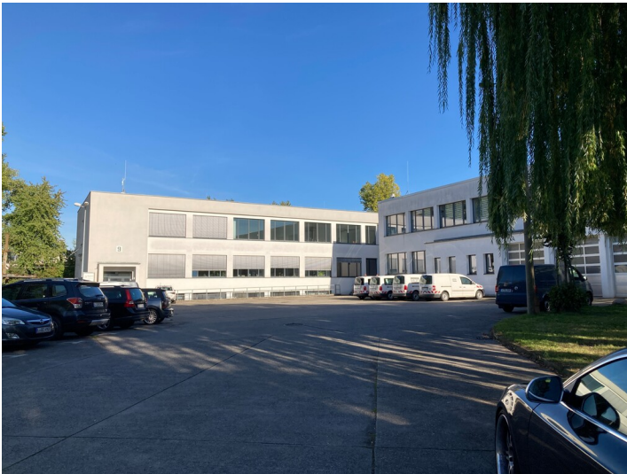
Werkstatt- und Bürogebäude des VEB Geophysik Leipzig von Nordost Fotograf/Urheber: Isabell Schmock-Wieczoreck
