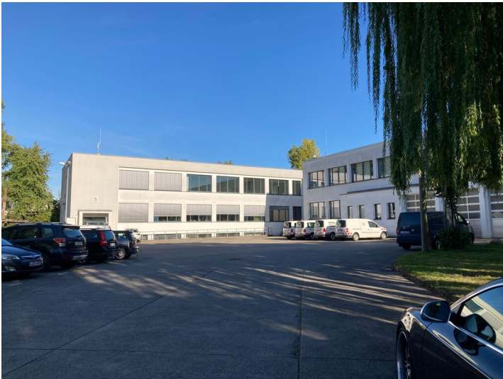
Werkstatt- und Bürogebäude des VEB Geophysik Leipzig von Nordost Fotograf/Urheber: Isabell Schmock-Wieczorek
