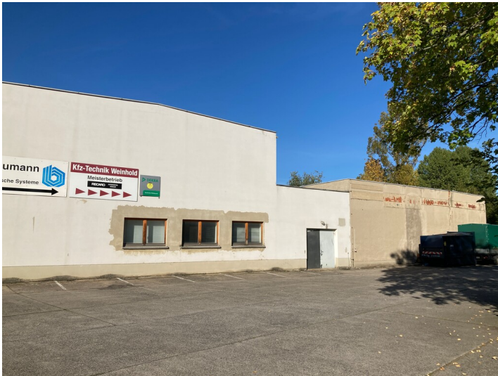
Rechnergebäude des VEB Geophysik Leipzig von Südwesten Fotograf/Urheber: Isabell Schmock-Wieczoreck
