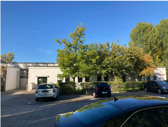
Zentrale Rechenstation des VEB Geophysik, errichtet als Zentrallager, von Süden Fotograf/Urheber: Isabell Schmock-Wieczorek
