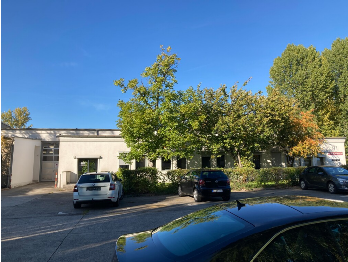
Zentrale Rechenstation des VEB Geophysik, errichtet als Zentrallager, von Süden Fotograf/Urheber: Isabell Schmock-Wieczorek
