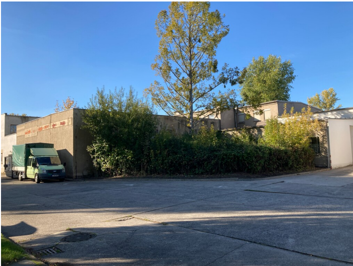
Garagenblock D des ehemaligen VEB Geophysik, mit zahlreichen Anbauten versehen, von Süd Fotograf/Urheber: Isabell Schmock-Wieczorek
