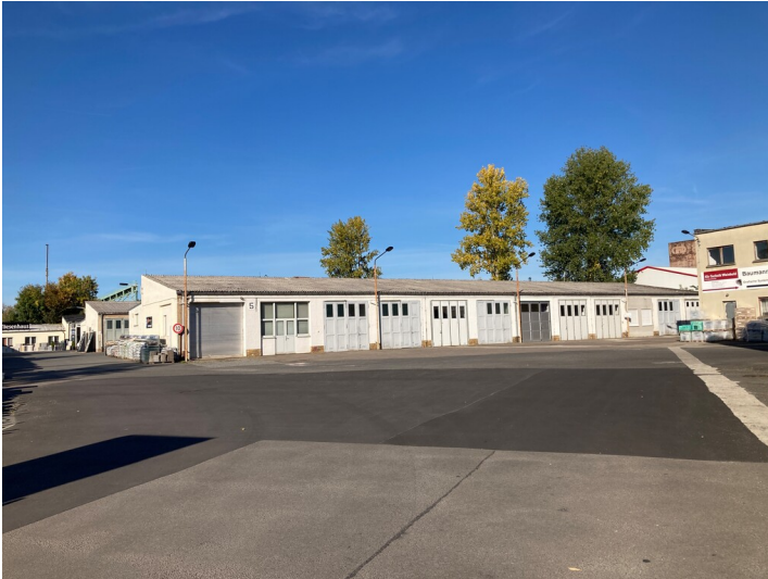
Garagenblock C des ehemaligen VEB Geophysik von Süd Fotograf/Urheber: Isabell Schmock-Wieczoreck
