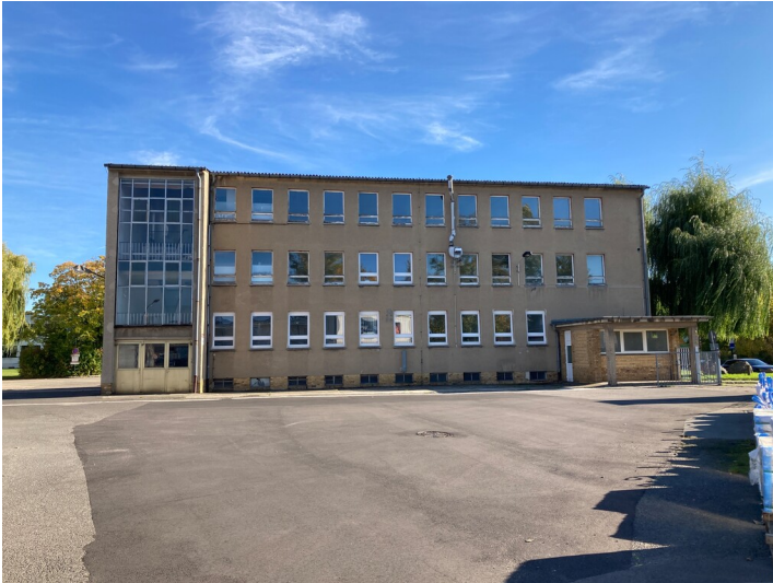
Betriebsgebäude des VEB Geophysik von Nordost Fotograf/Urheber: Isabell Schmock-Wieczorek
