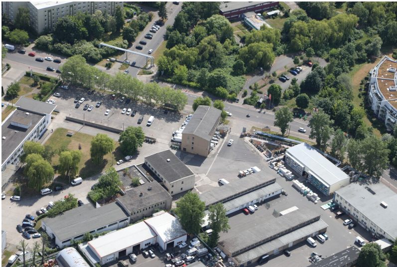
Betriebsgelände im Bildmittelgrund, Luftbildaufnahme aus nordöstlicher Richtung Fotograf/Urheber: Ronald Heynowski
