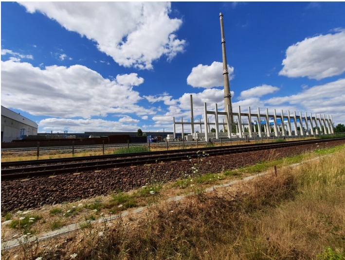
Stahl- und Hartgusswerk Bösdorf aus östlicher Richtung Fotograf/Urheber: Isabell Schmock-Wieczorek
