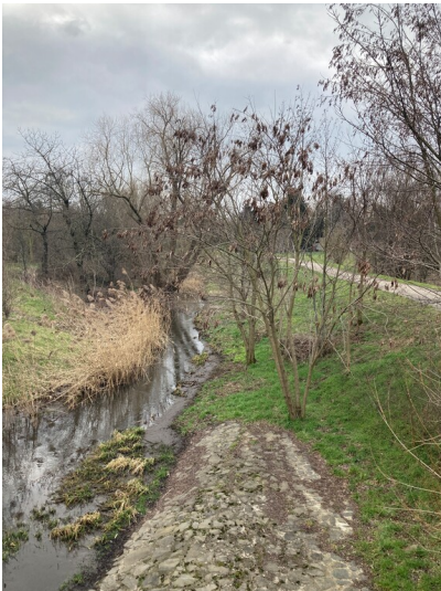
Blick auf den kanalisiertem Fluss bei Lucka mit Blick nach Nordwest Fotograf/Urheber: Isabell Schmock-Wieczorek
