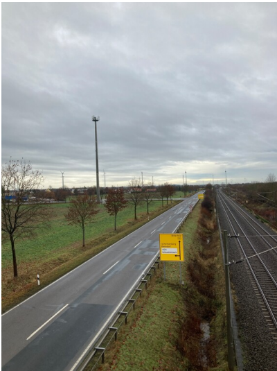
Blick in nordwestliche Richtung von Straßenüberführung Feldweibel-Boldt-Straße Fotograf/Urheber: Isabell Schmock-Wieczorek
