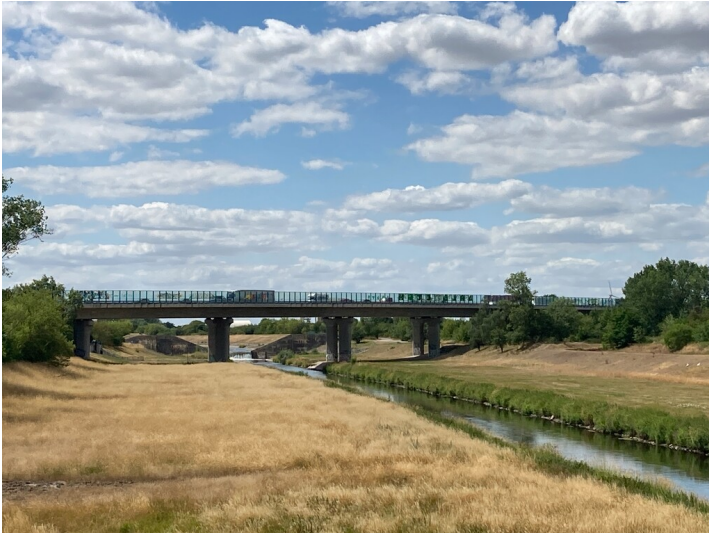
Knautnaundorfer Straßenbrücke (B 186) von Norden fotografiert (Erikenbrücke) Fotograf/Urheber: Isabell Schmock-Wieczorek
