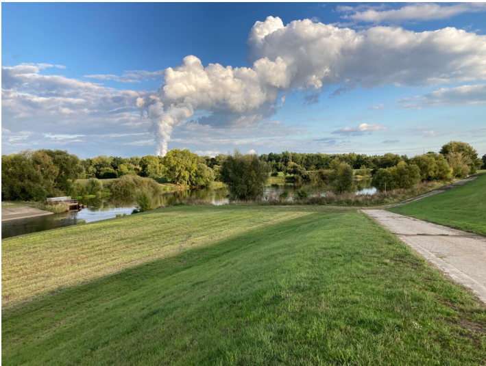
Geschiebefalle aus nördlicher Richtung Fotograf/Urheber: Isabell Schmock-Wieczorek
