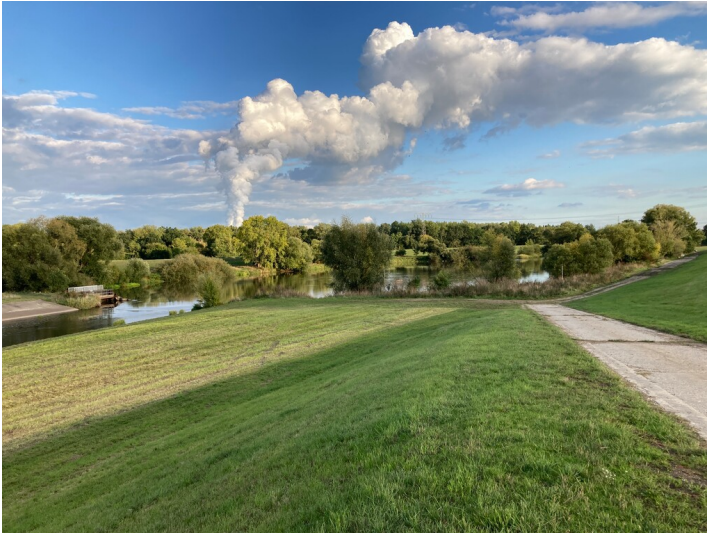
Geschiebefalle aus nördlicher Richtung Fotograf/Urheber: Isabell Schmock-Wieczorek
