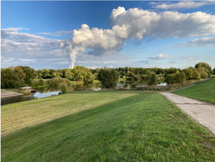
Geschiebefalle aus nördlicher Richtung Fotograf/Urheber: Isabell Schmock-Wieczorek
