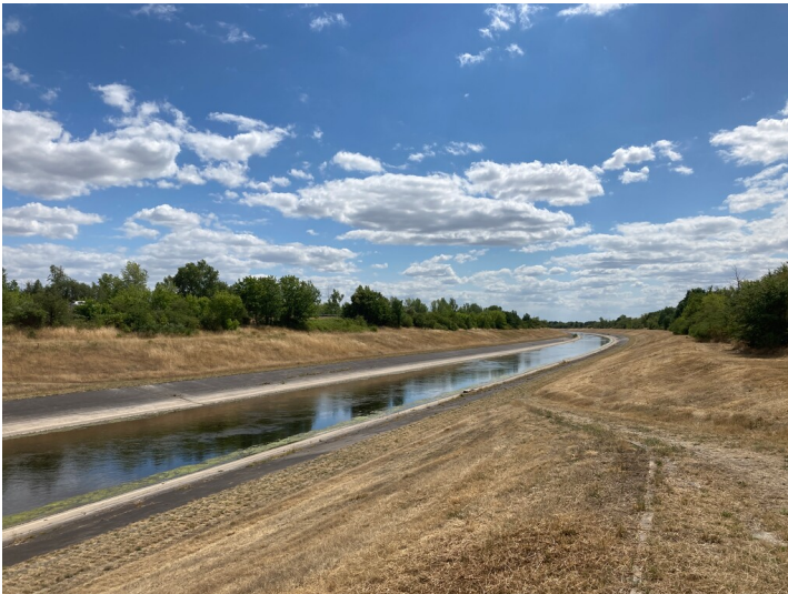
Betonelster auf Höhe Hartmannsdorf-Knautnaundorf mit Blick Richtung Süden Fotograf/Urheber: Vincent Haburaj
