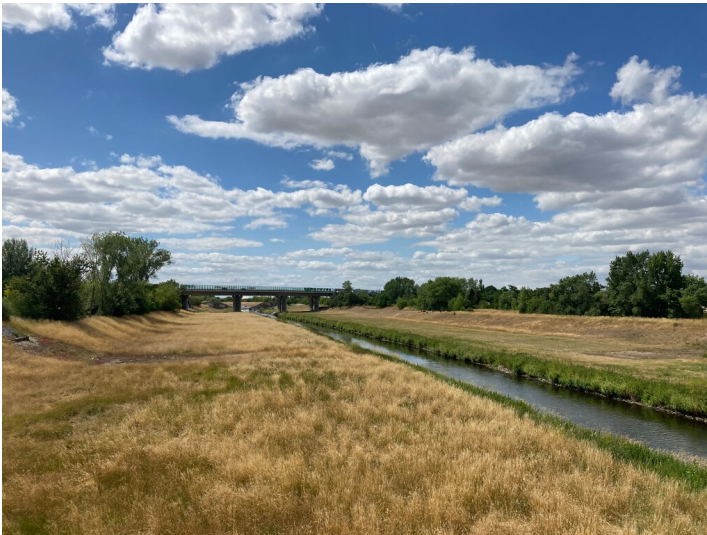
Objektgruppe Wasserbauwerk Weißer Elster auf Höhe Hartmannsdorf-Knautnaundorf Fotograf/Urheber: Vincent Haburaj
