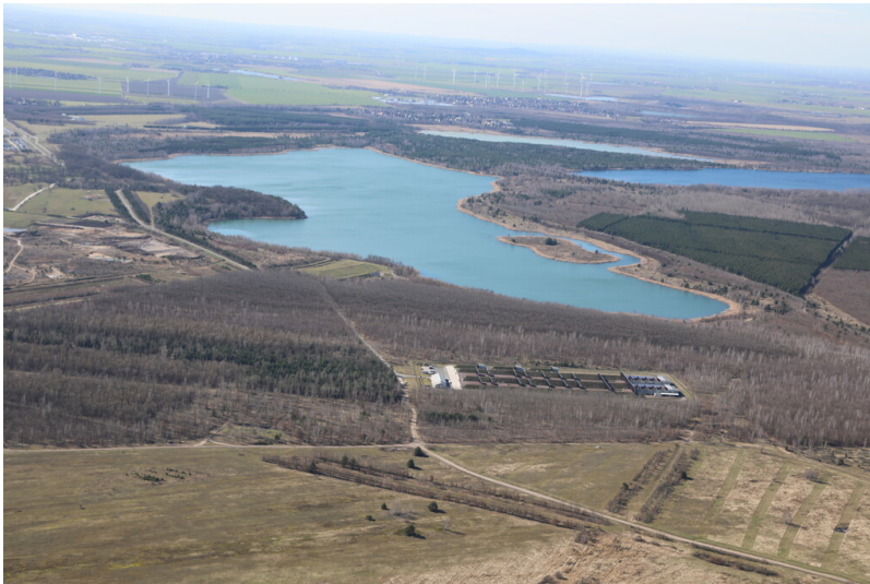
Luftbildaufnahme aus südöstlicher Richtung Fotograf/Urheber: Ronald Heynowski
