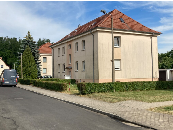
westlicher Straßenzug mit Einzelwohnhäusern Fotograf/Urheber: Josephine Dressler
