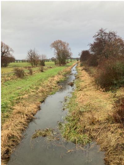
Wasserbauwerk Lober-Leine-Kanal Fotograf/Urheber: Isabell Schmock-Wieczorek
