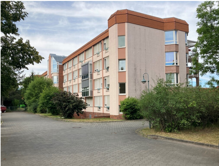
Seniorenpflegeheim mit Blick Richtung Nordost Fotograf/Urheber: Josephine Dressler
